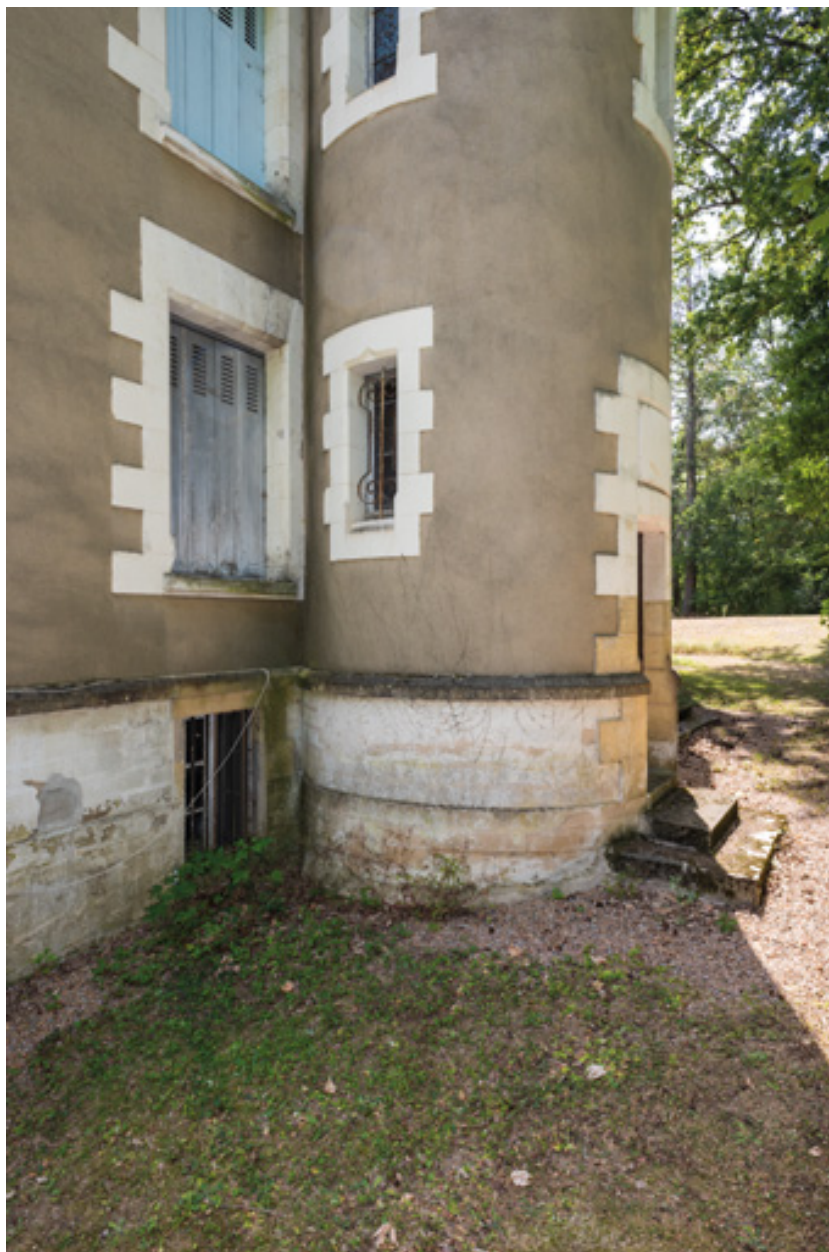
Partie inférieure de la tour d'escalier.
