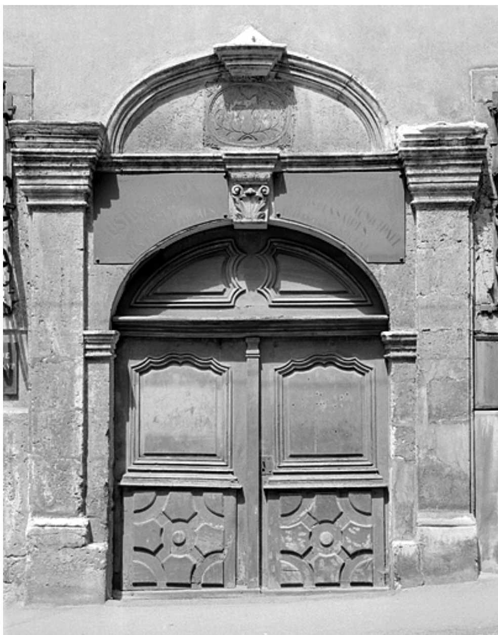
Portail sur la rue du Château.
