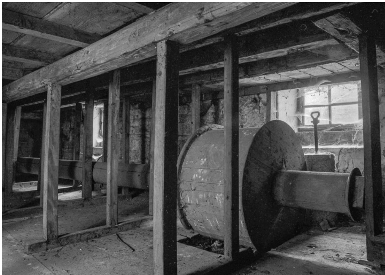
Dessous de scène. Tambour de la machinerie (1987).
