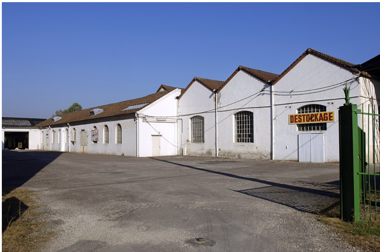
Façades sud de l'atelier de bobinage.
