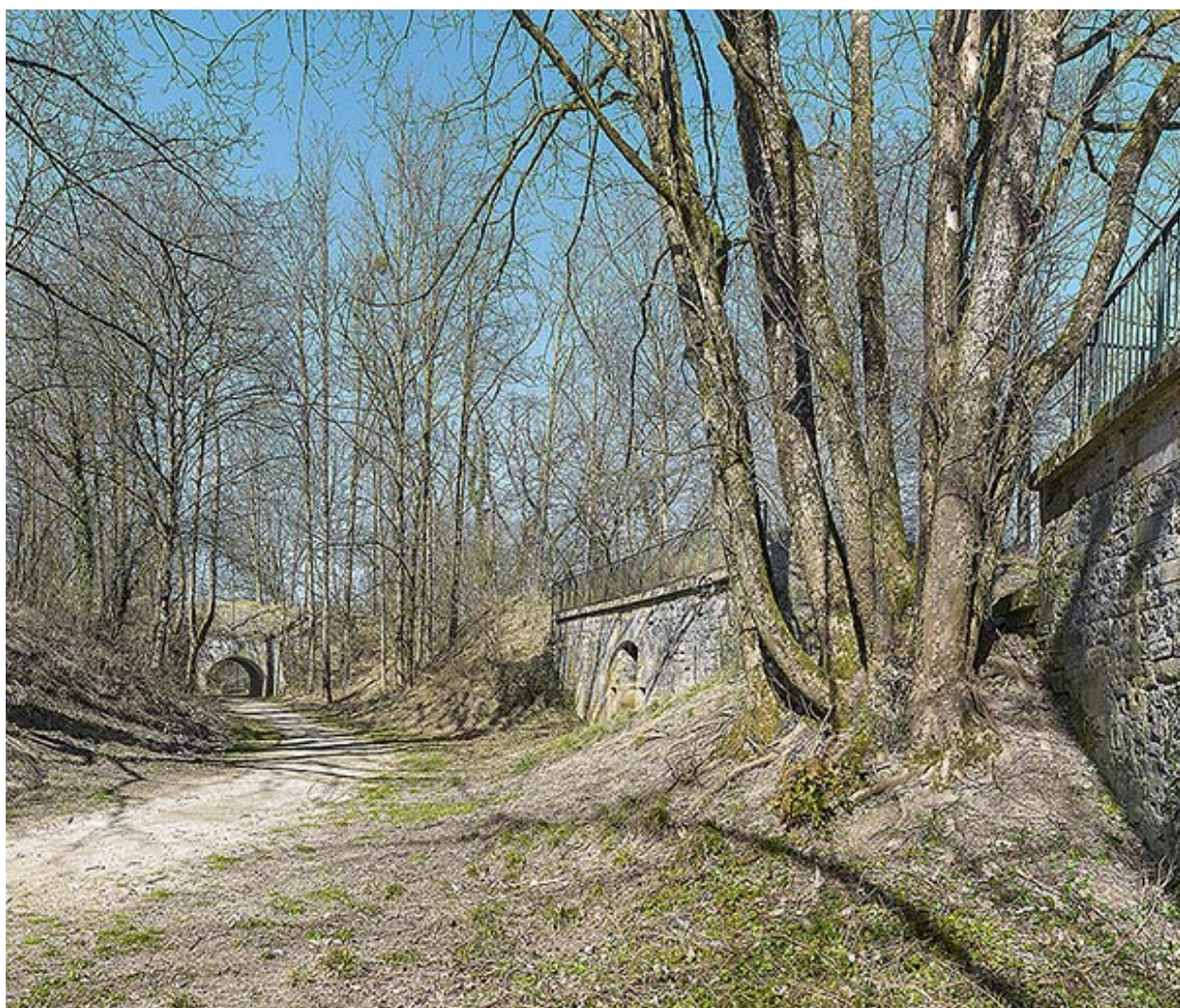
Traverse-abri, rue des Remparts.
