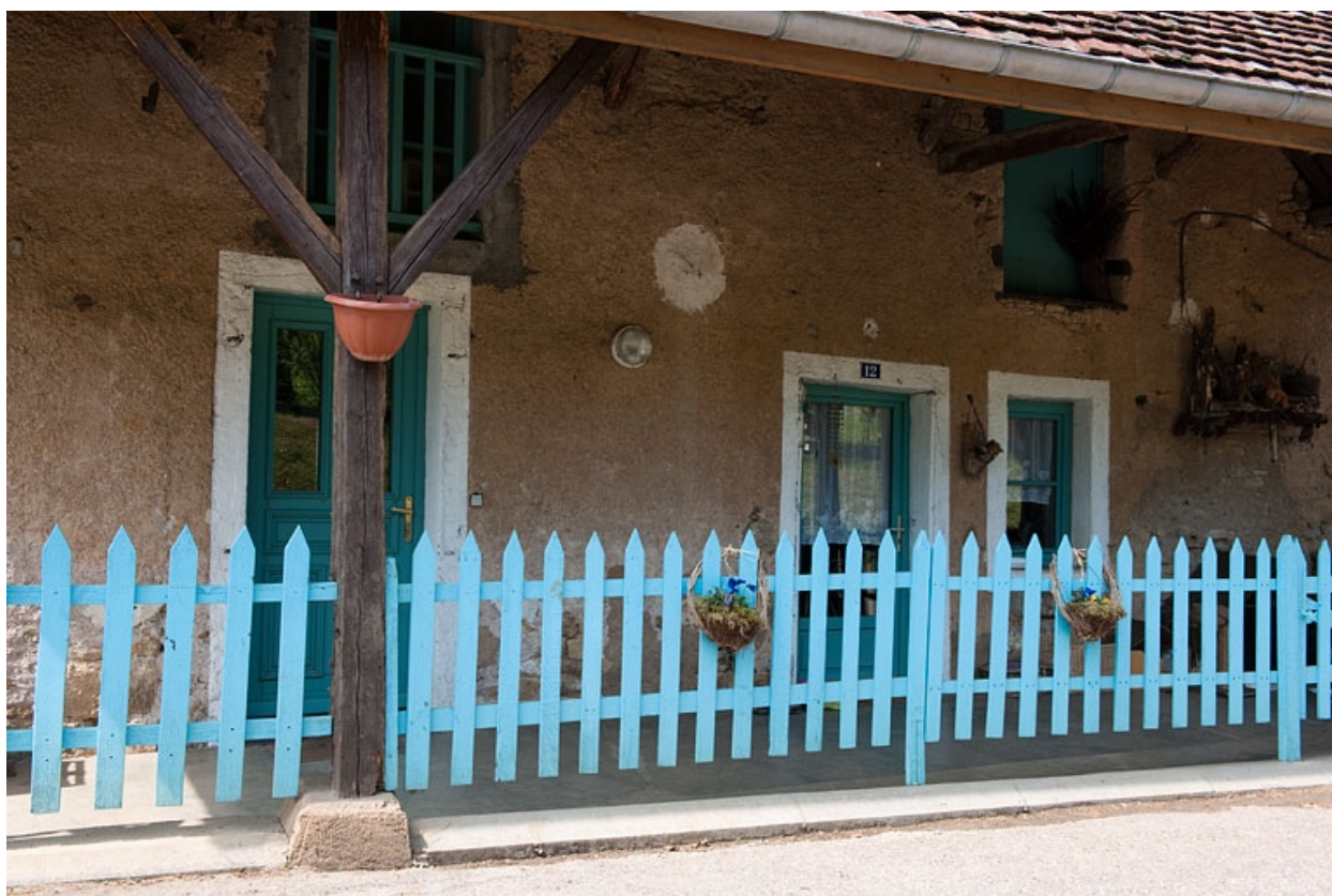
Façade antérieure, vue rapprochée.
