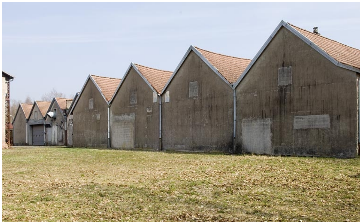
Pignons ouest de l'atelier de filature.
