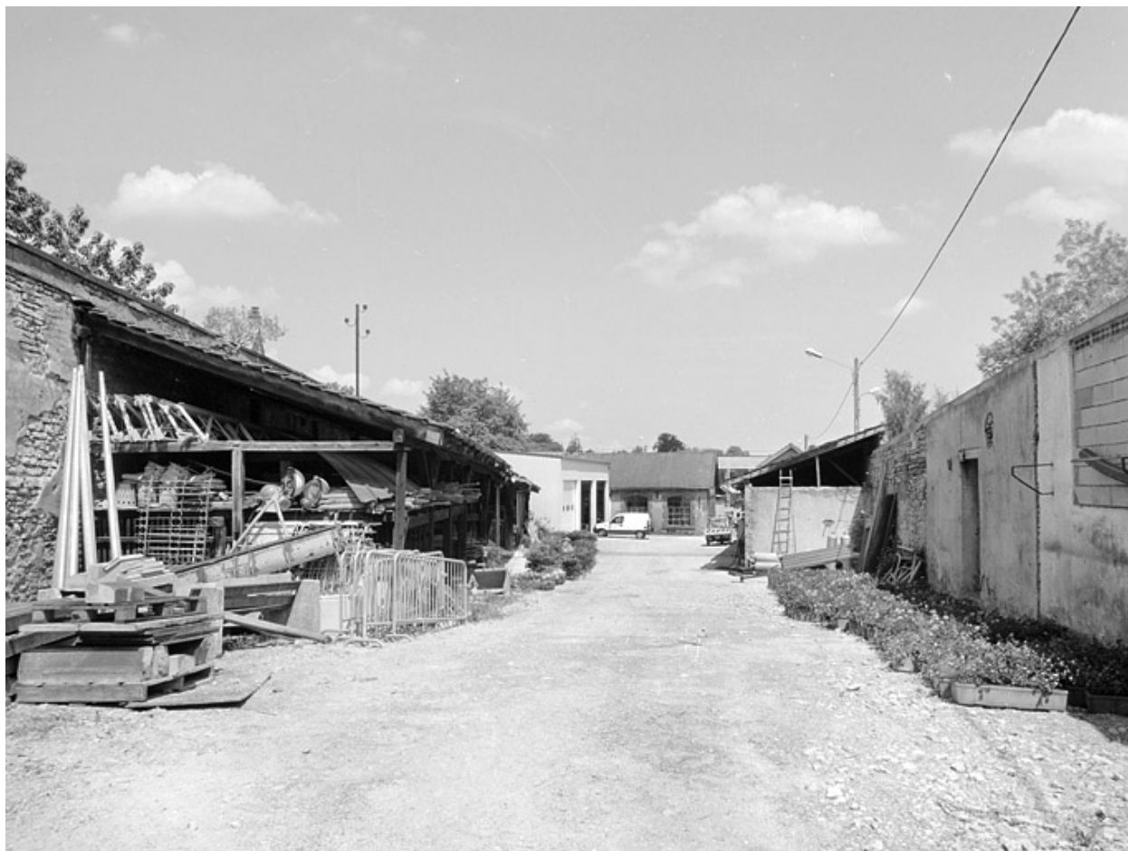
La cour des magasins généraux.
