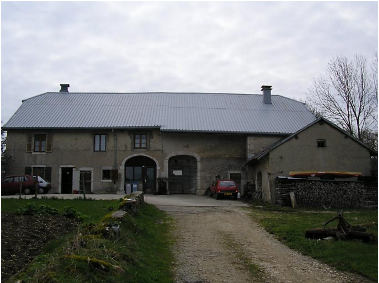
Vue générale de la façade antérieure.
