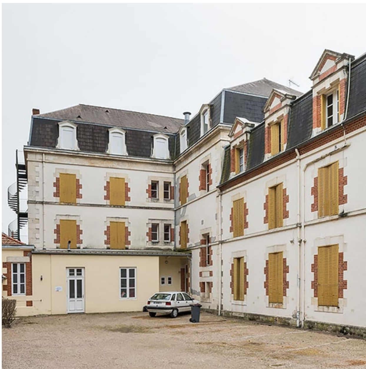
Façade sur la cour.
