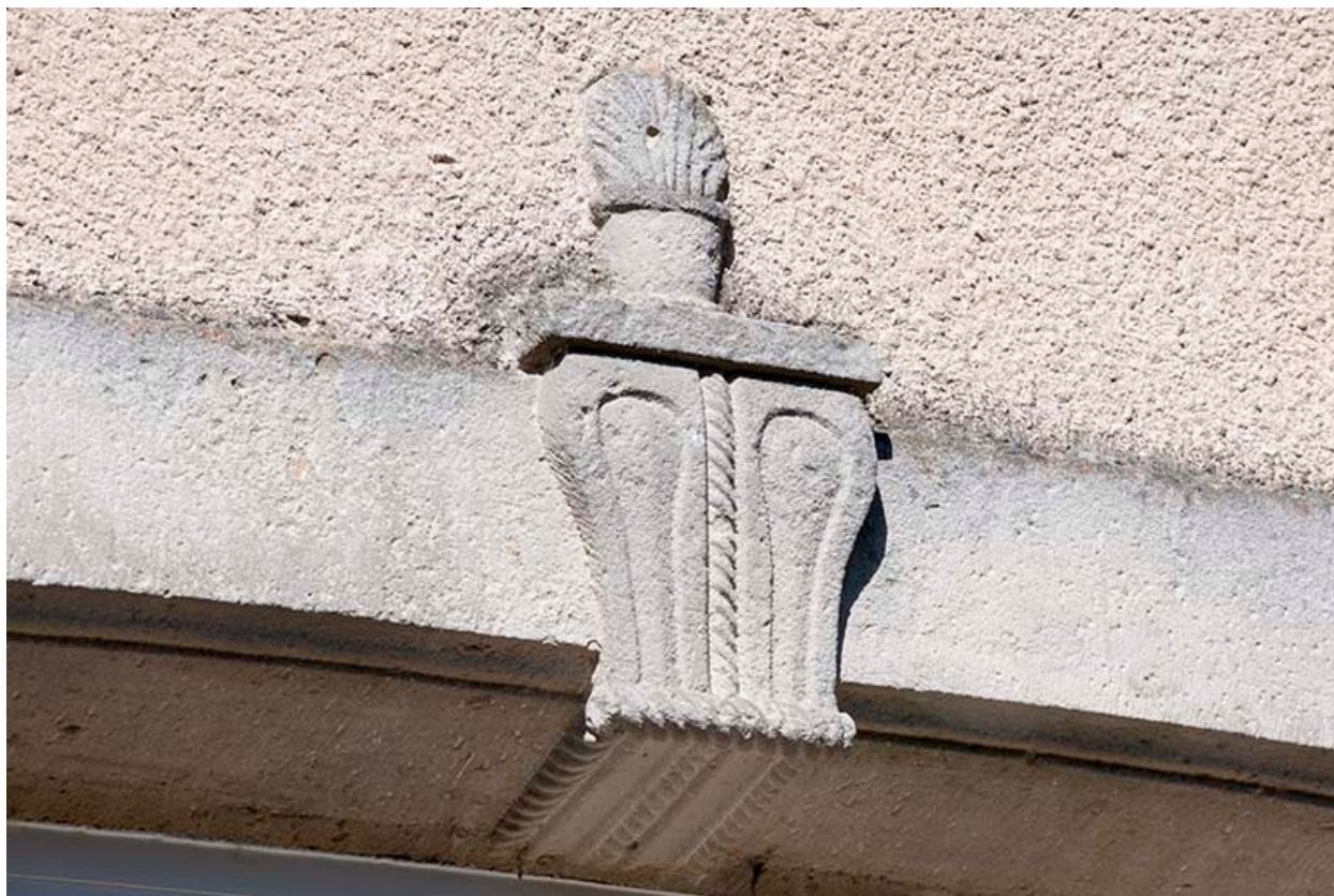
Détail de la porte.
