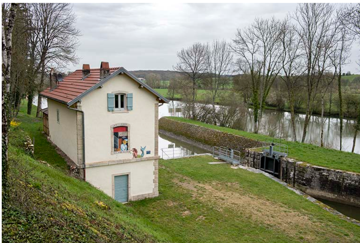
le site d'écluse, vue d'ensemble.
