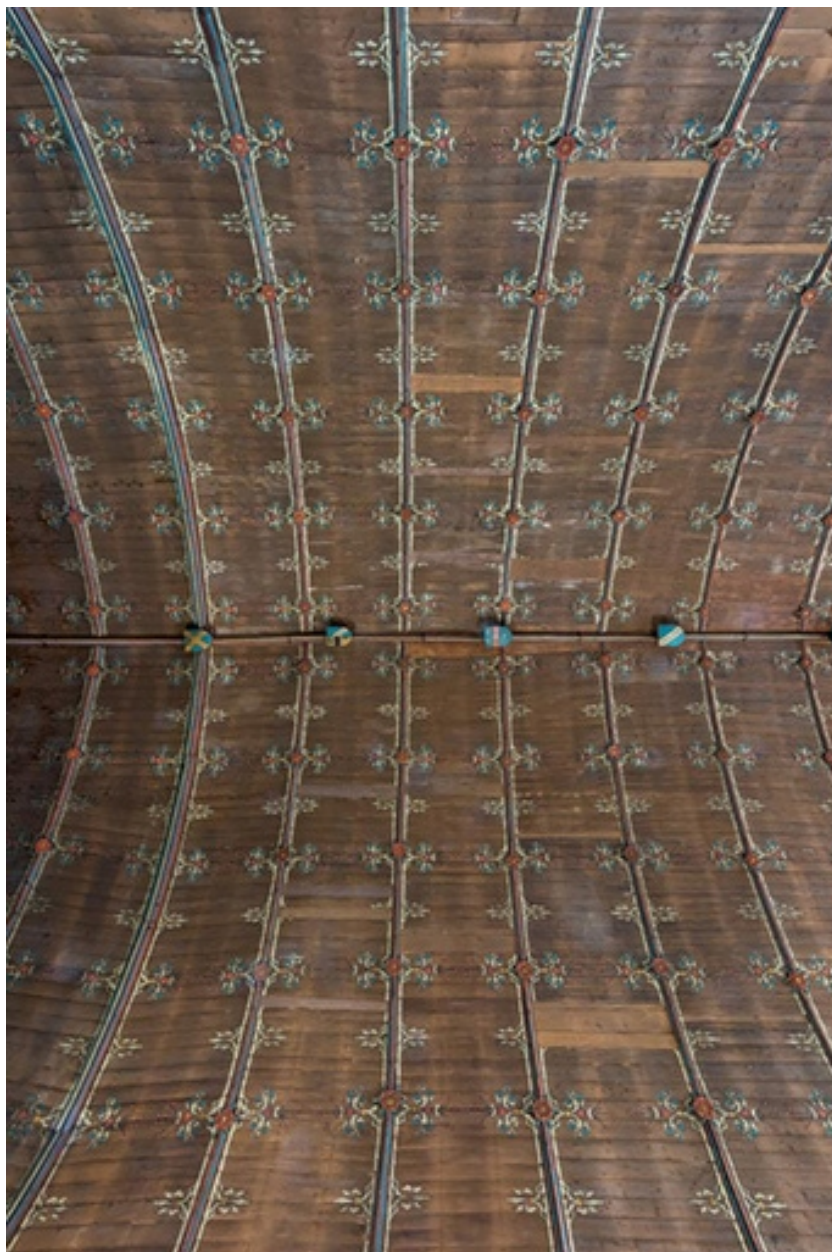
Nef, charpente lambrissée : vue d'ensemble.
