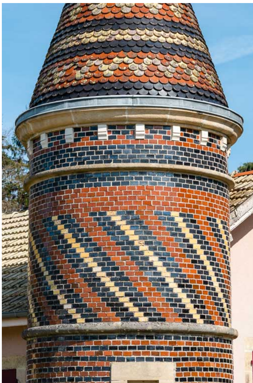
Détail de la tourelle d'angle.
