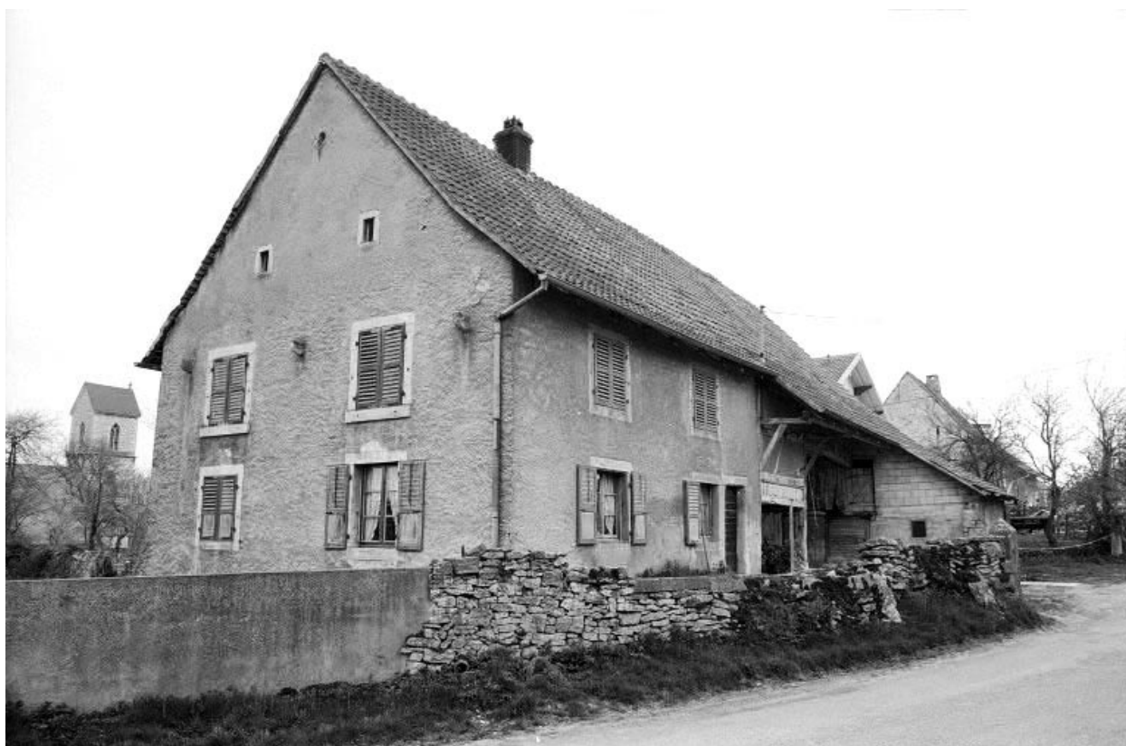
Façades antérieure et latérale gauche.
