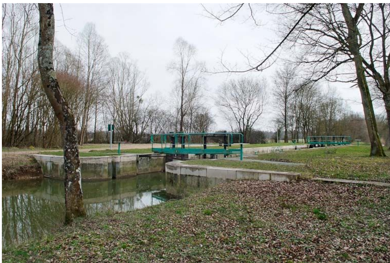
Tête amont de l'écluse.
