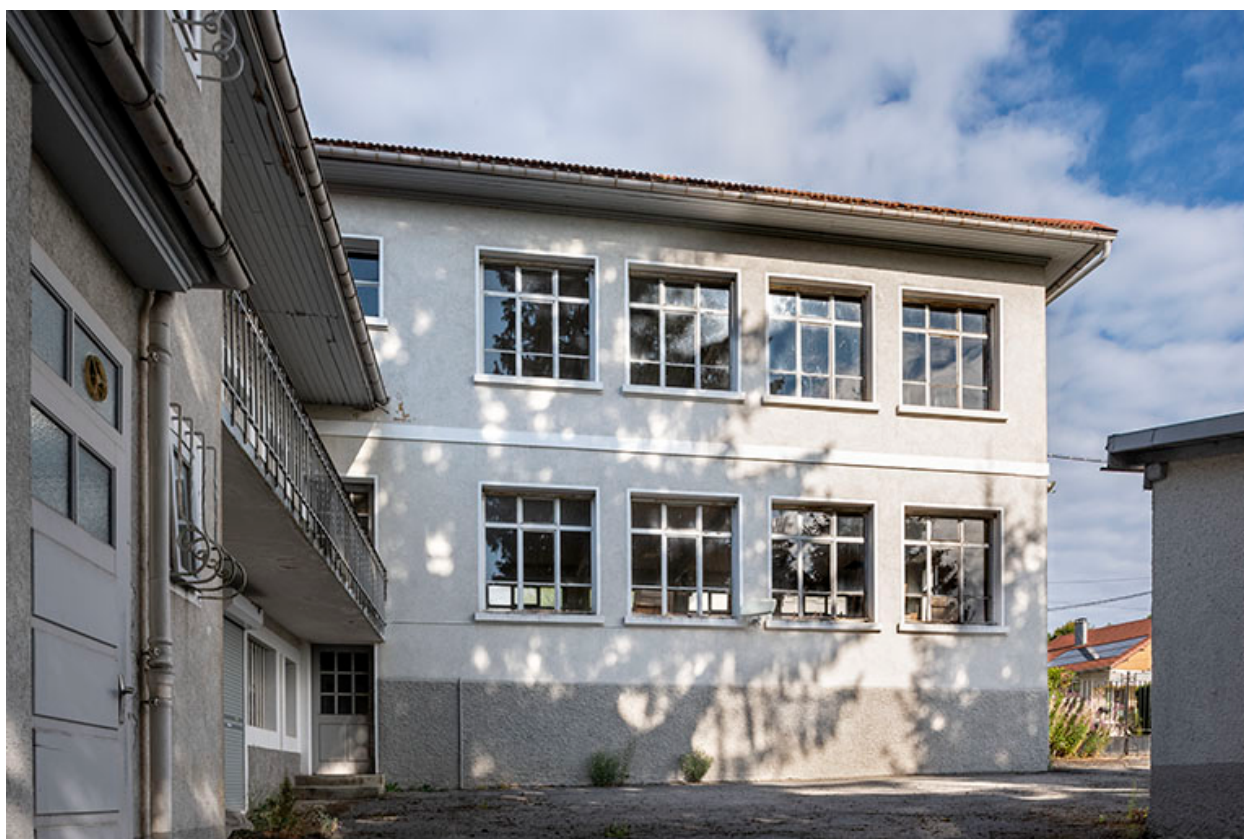
Atelier de 1930 : façade postérieure (est).
