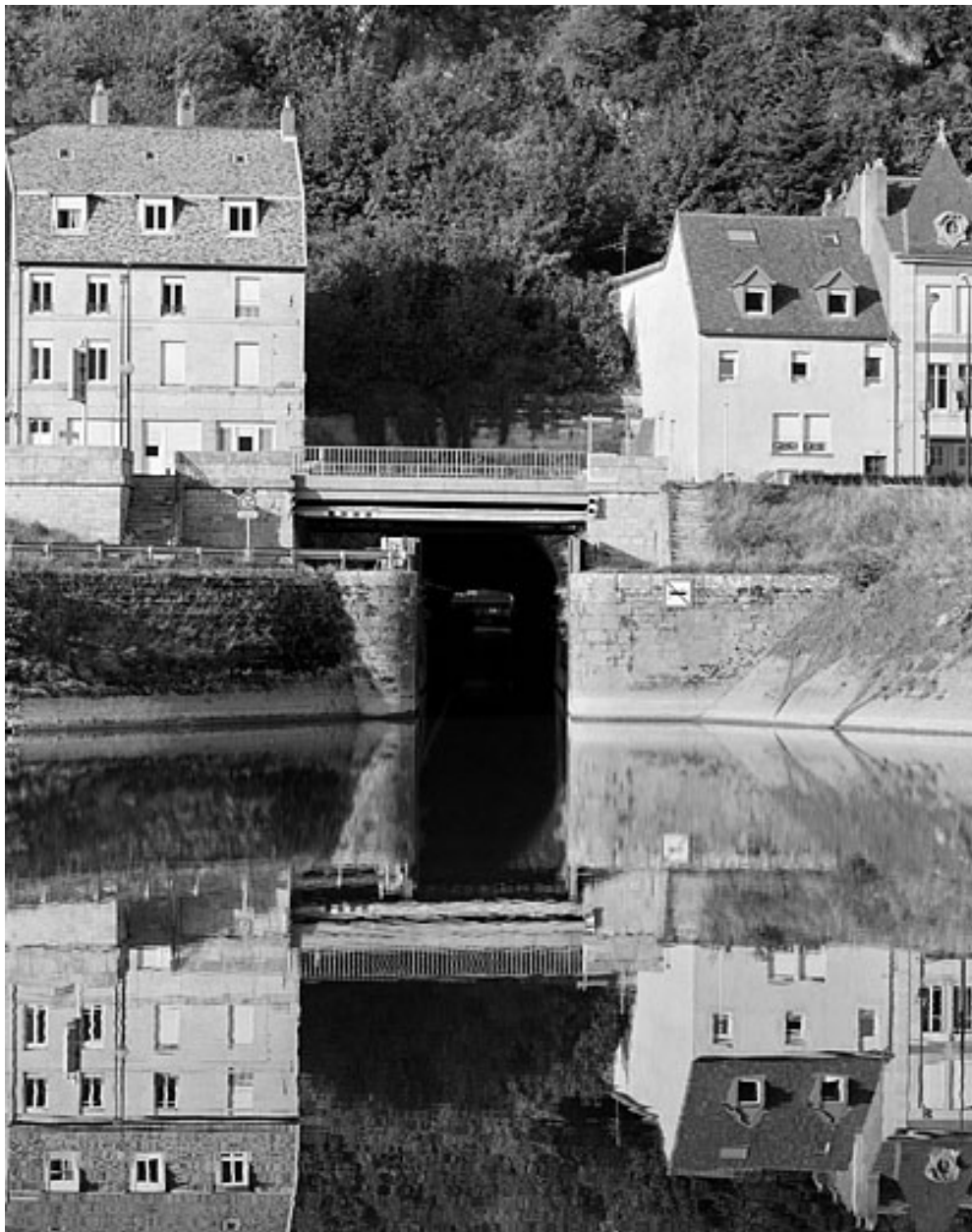
Besançon, tunnel sous la citadelle : porte de garde et extrémité amont.
