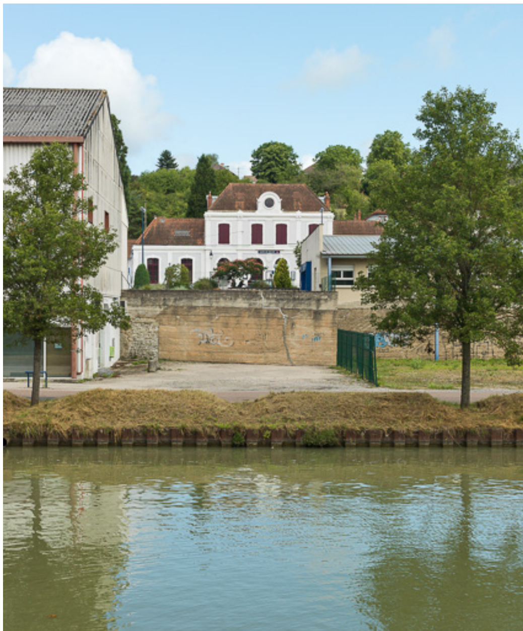
Vue de la gare et du canal.
