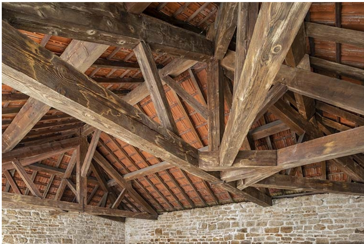
La charpente du lavoir.
