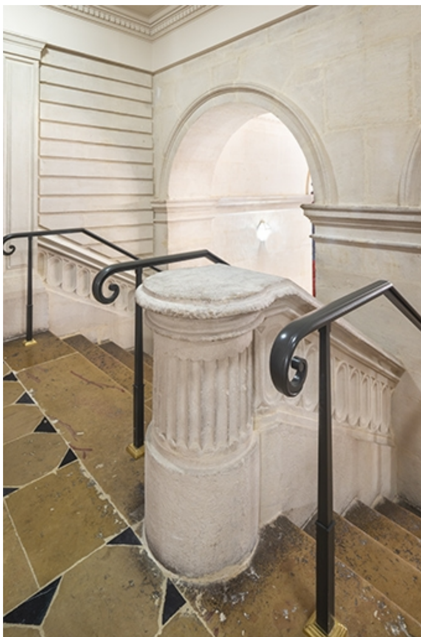
Vestibule, palier de l'escalier : départ de rampe.
