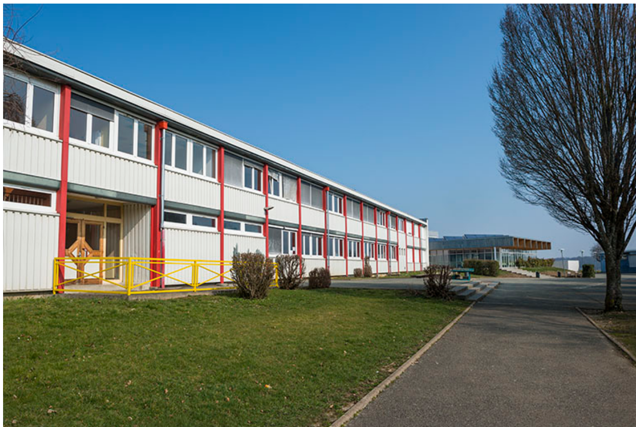
Façade sud de l'externat sud.
