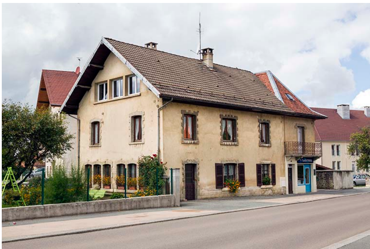
Façades antérieure et latérale gauche.
