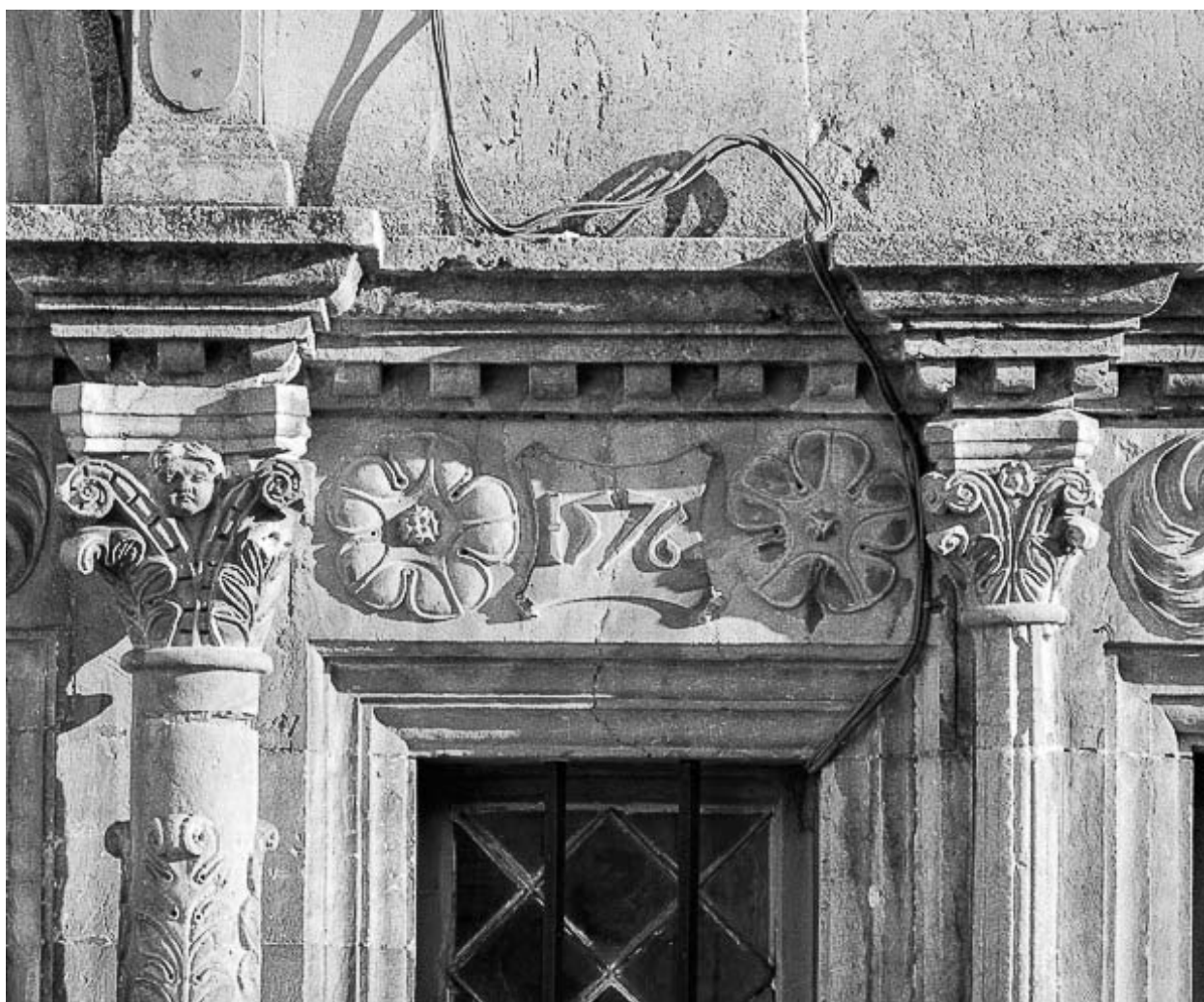
Linteau de fenêtre du rez-de-chaussée.
