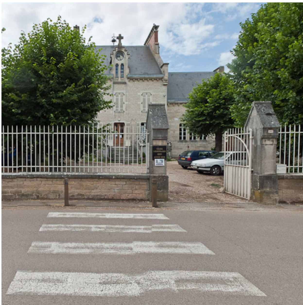
Vue du pensionnat depuis la route.
