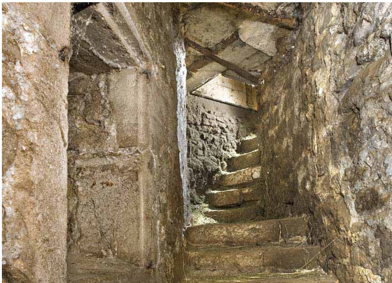
Escalier en pierre.
