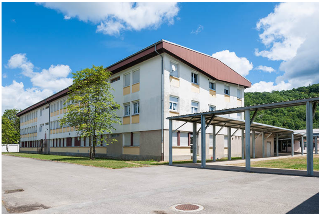
Internat : façade postérieure.
