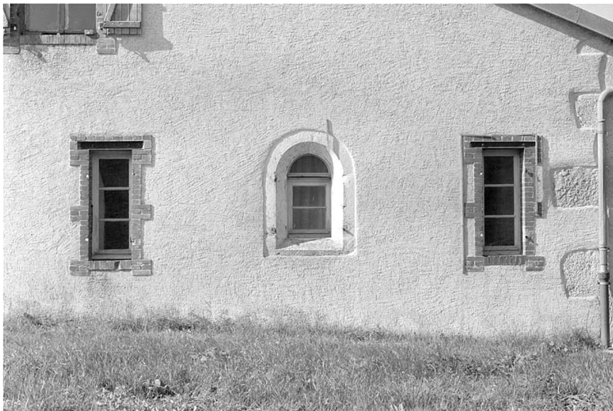
Détail des fenêtres de la fromagerie.
