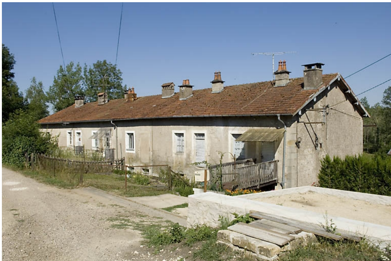
Logement ouvrier collectif (impasse Albert Ricot).
