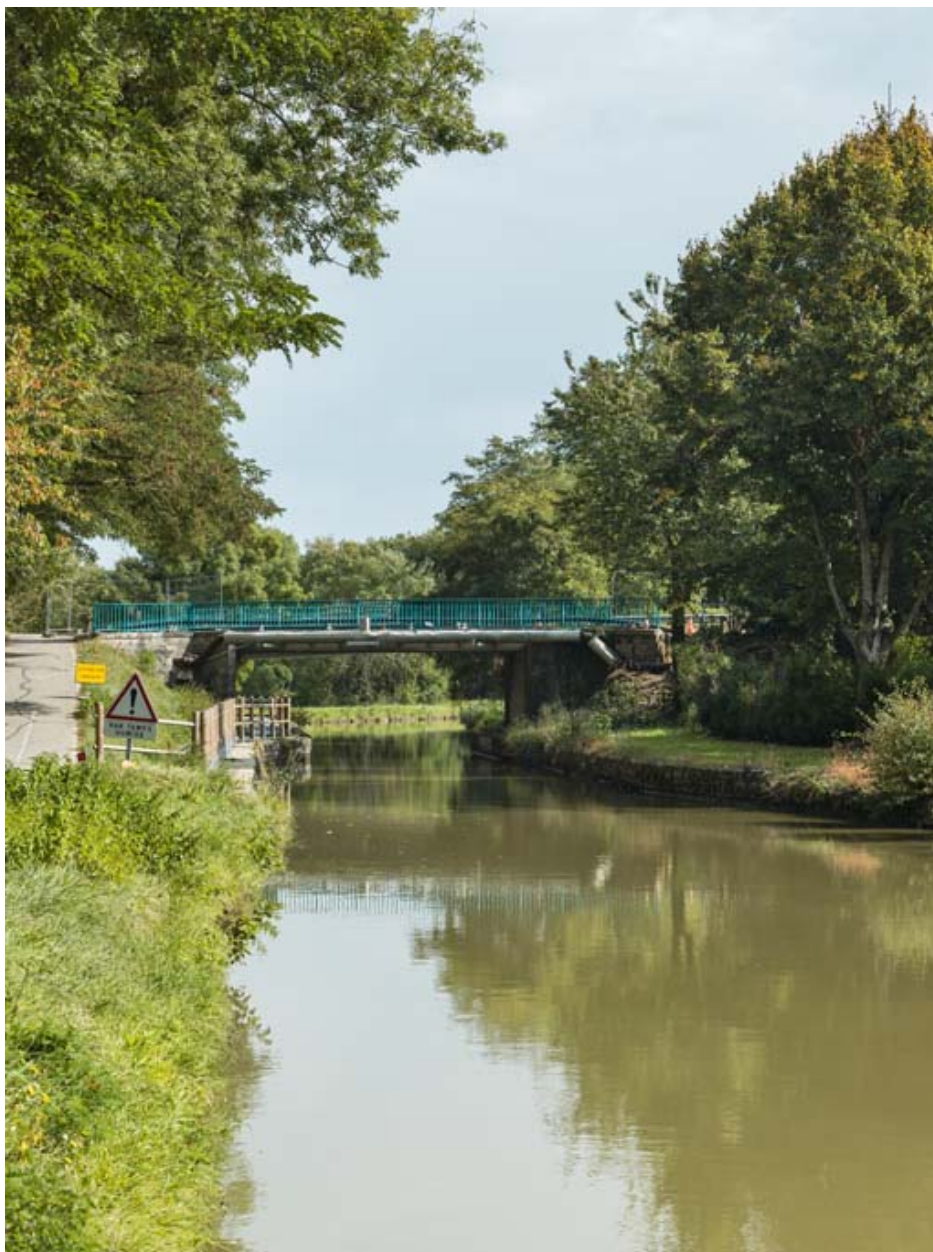
Vue d'ensemble du pont.
