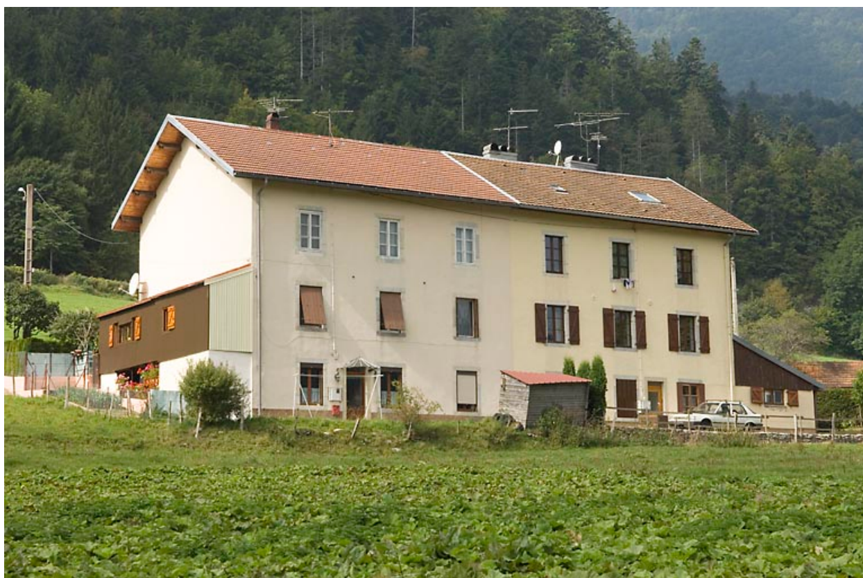
Immeuble à logements, façade postérieure.
