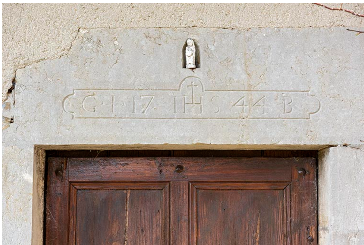
Façade ouest : linteau daté 1744.
