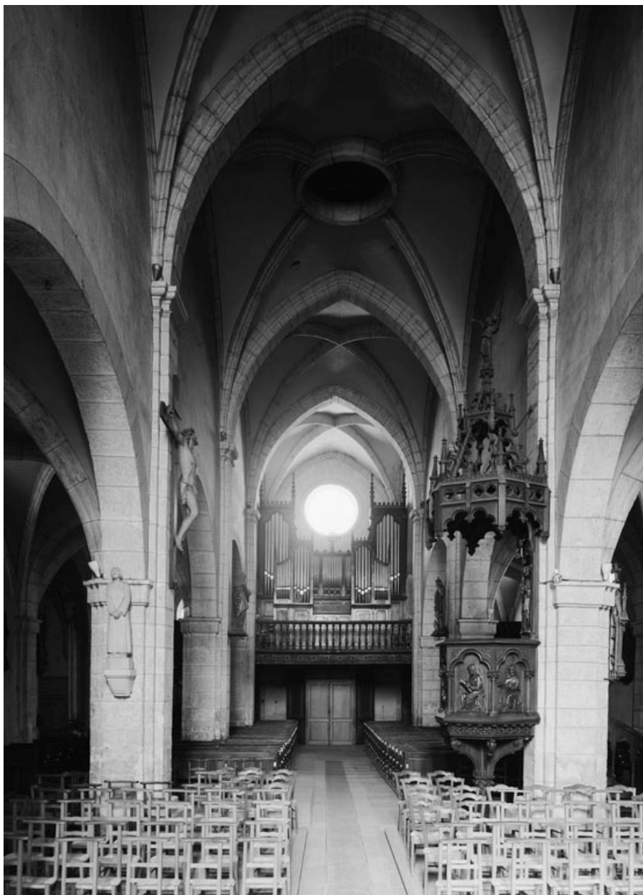
Nef, vue depuis le chœur.
