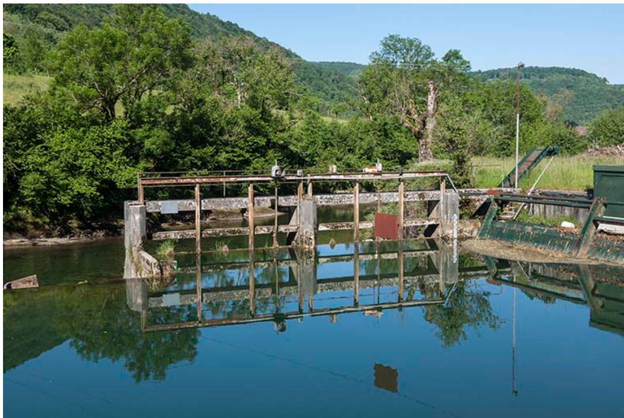
Vannage du barrage.
