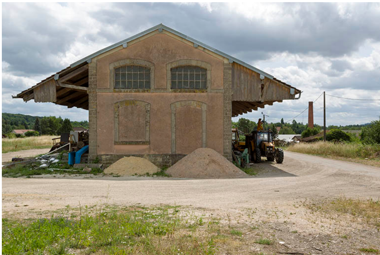
Le hangar de l'ancienne gare.
