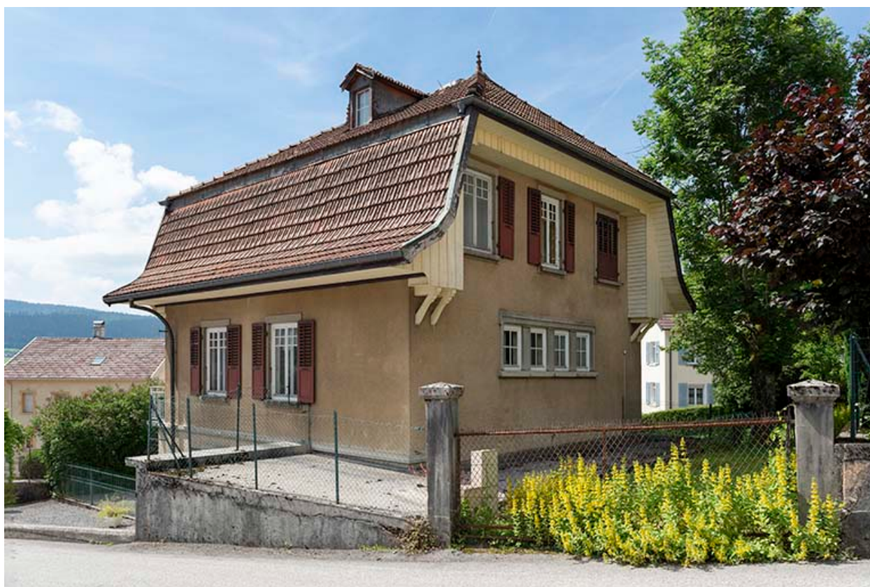
Façades postérieure et latérale droite.
