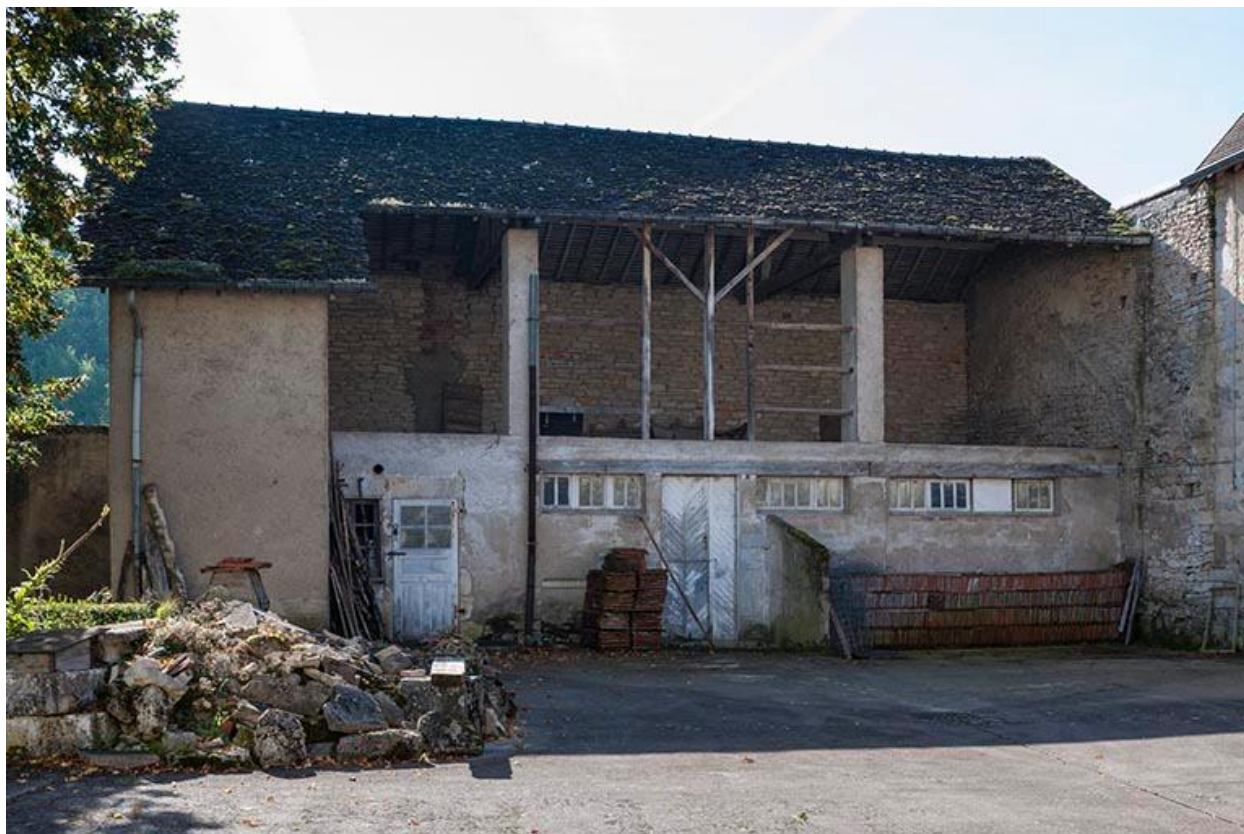
Dépendances situées au sud-ouest de la cour
