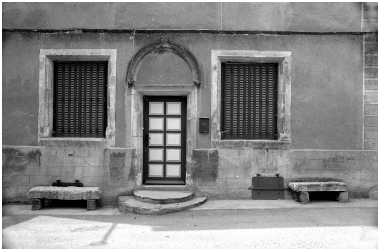
Détail : le rez-de-chaussée.
