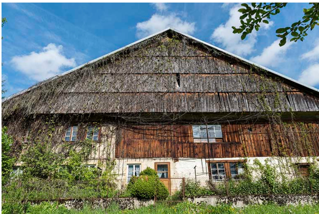
Façade antérieure, vue en contre-plongée.
