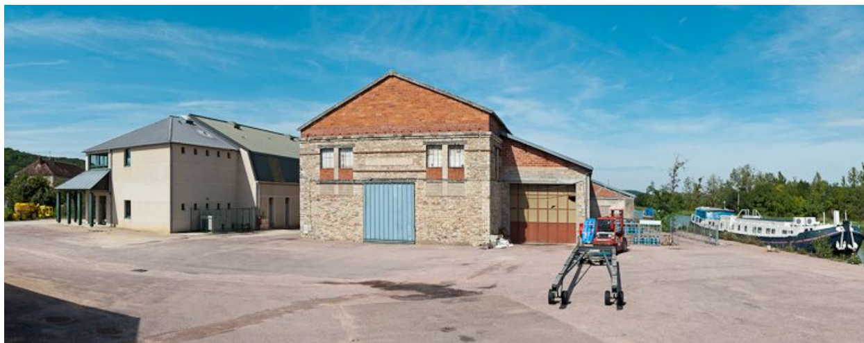
Vue de l'ancienne usine à chaux.
