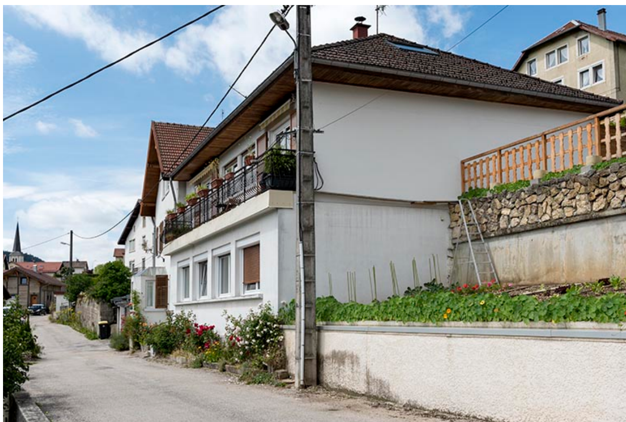
Façades antérieure et latérale droite.
