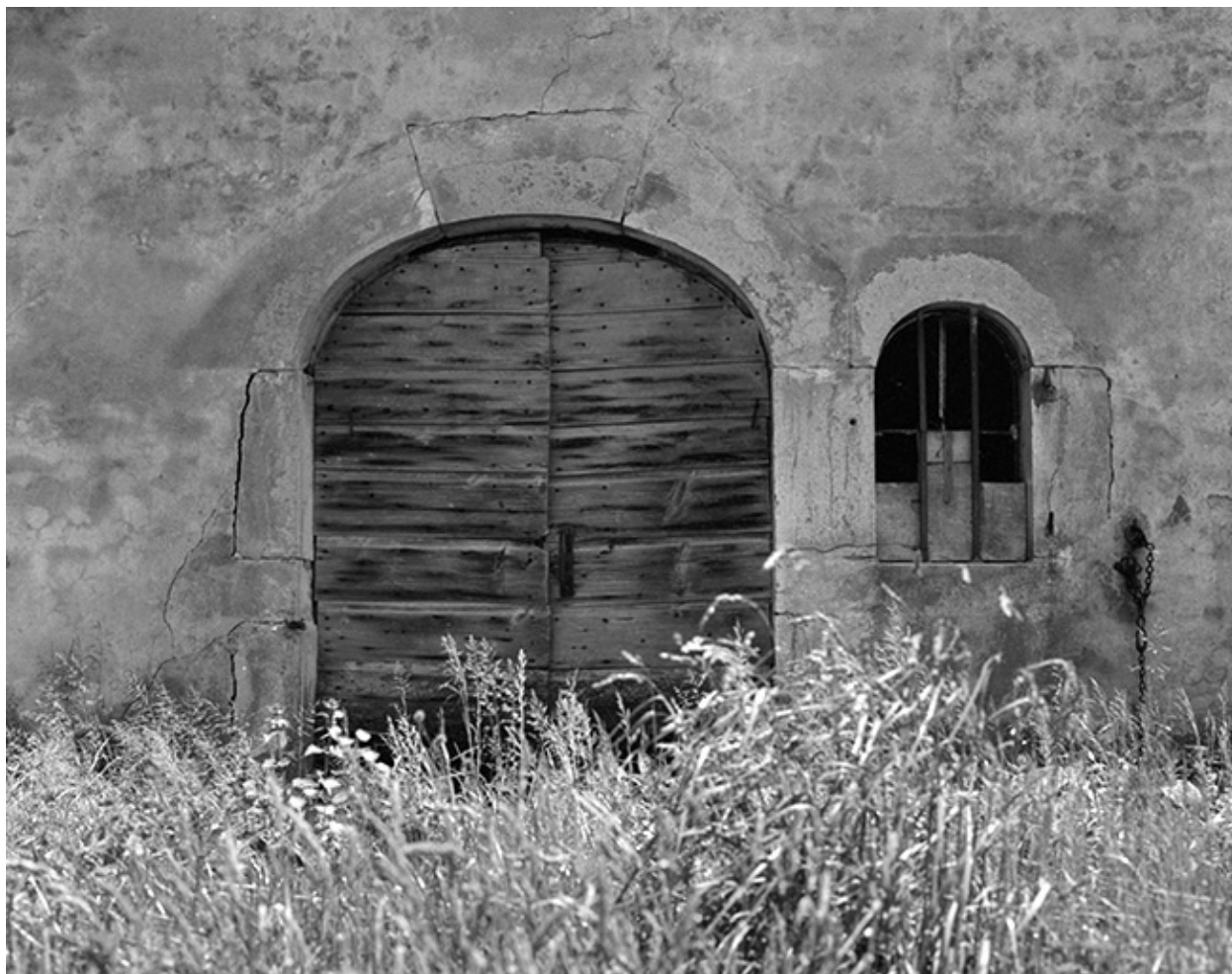
Détail : porte et fenêtre de l'étable en 1979.
