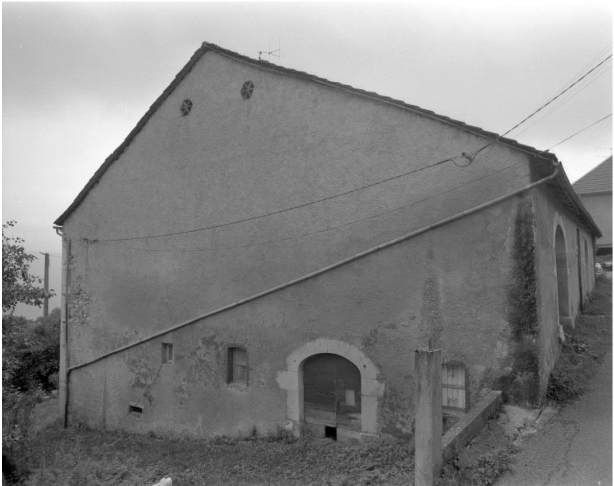
Face droite avec accès à l'étable.
