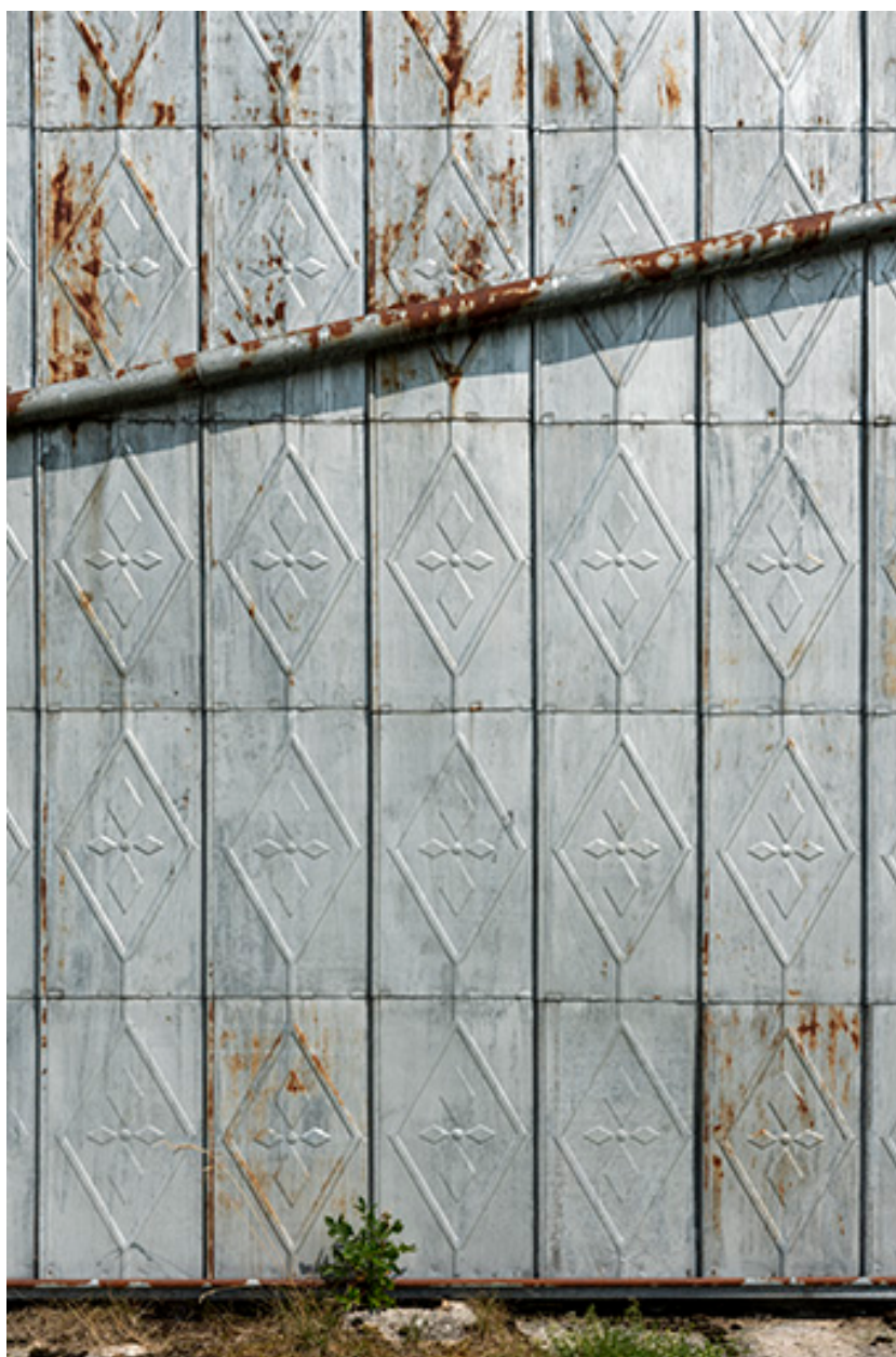
Essentage métallique sur le mur pignon de l'aile occidentale.
