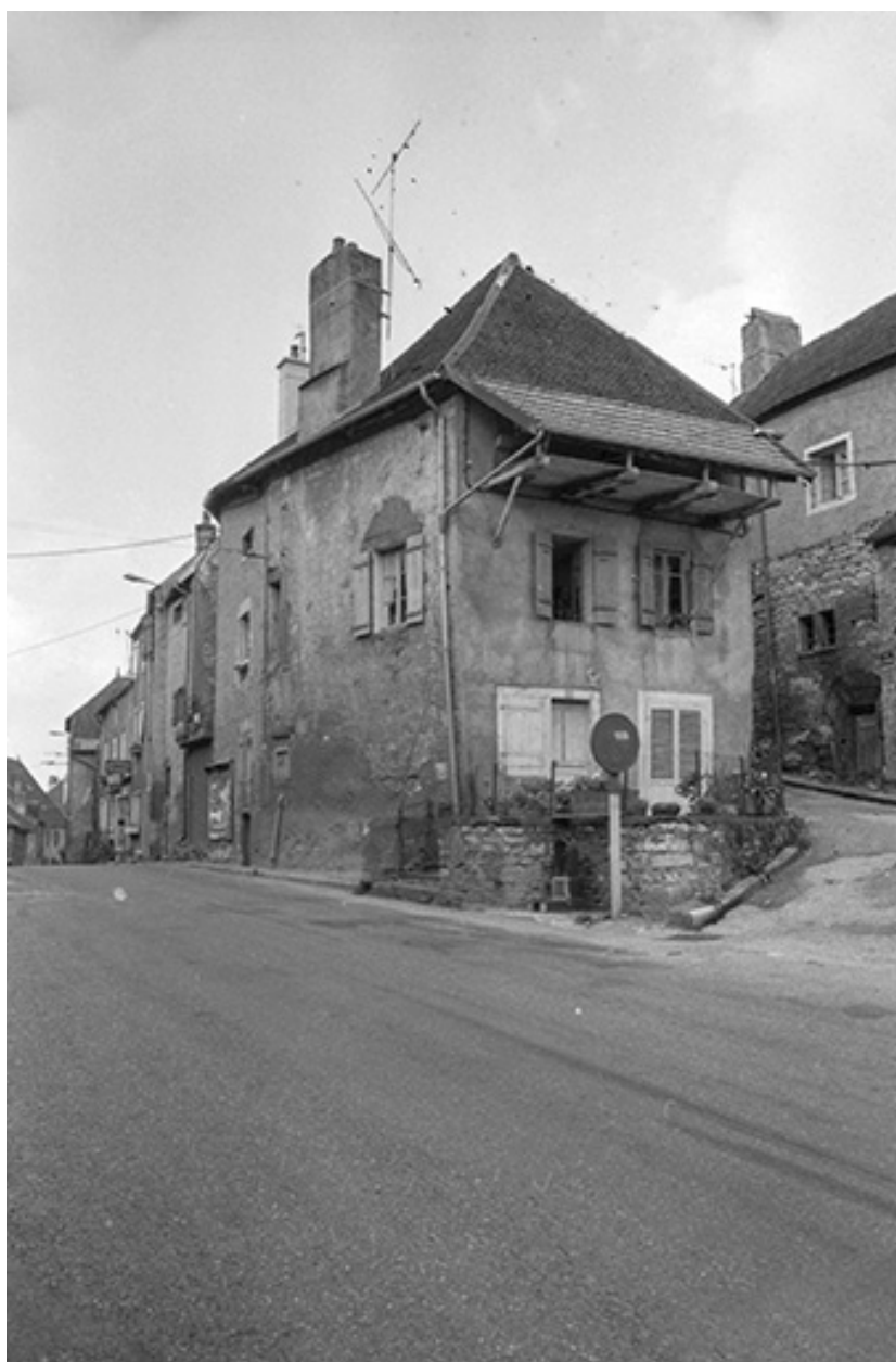
Maison située 18 rue Vanoise : vue d'ensemble.
