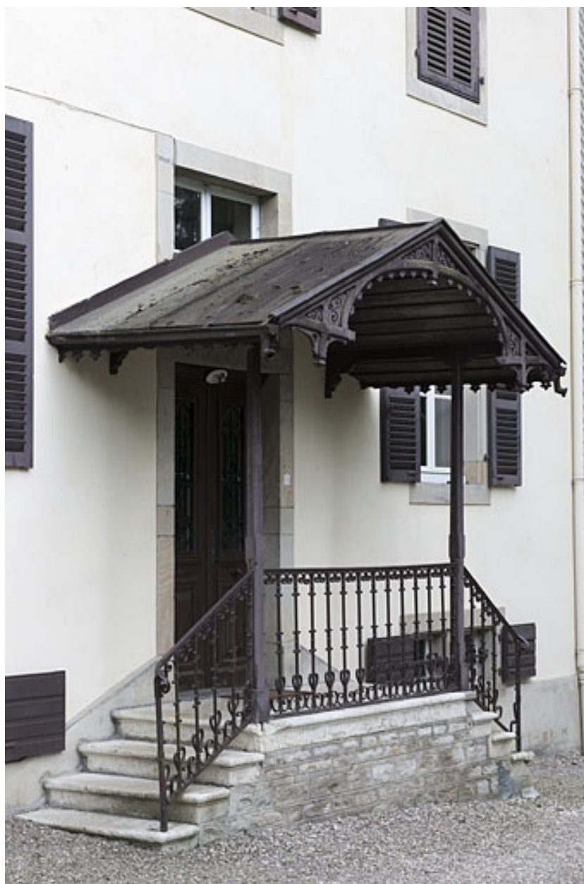
Entrée de la façade nord.
