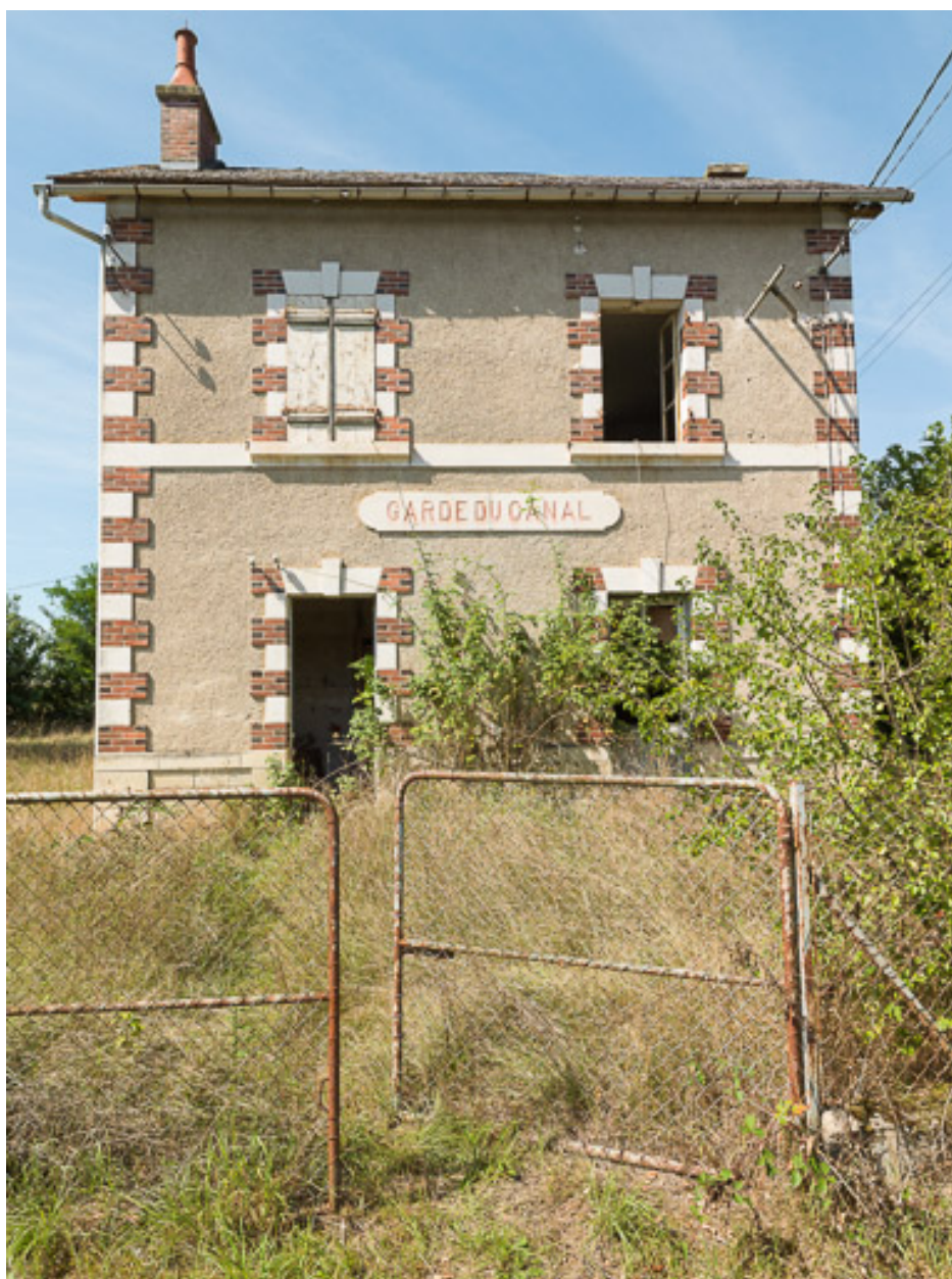
Vue d'une maison de barragiste.
