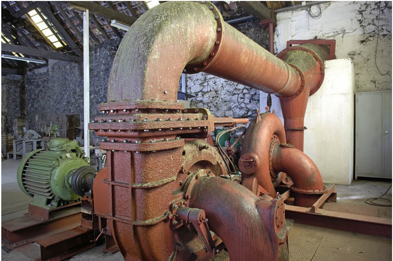
Forge du Haut. Vue rapprochée des turbines.
