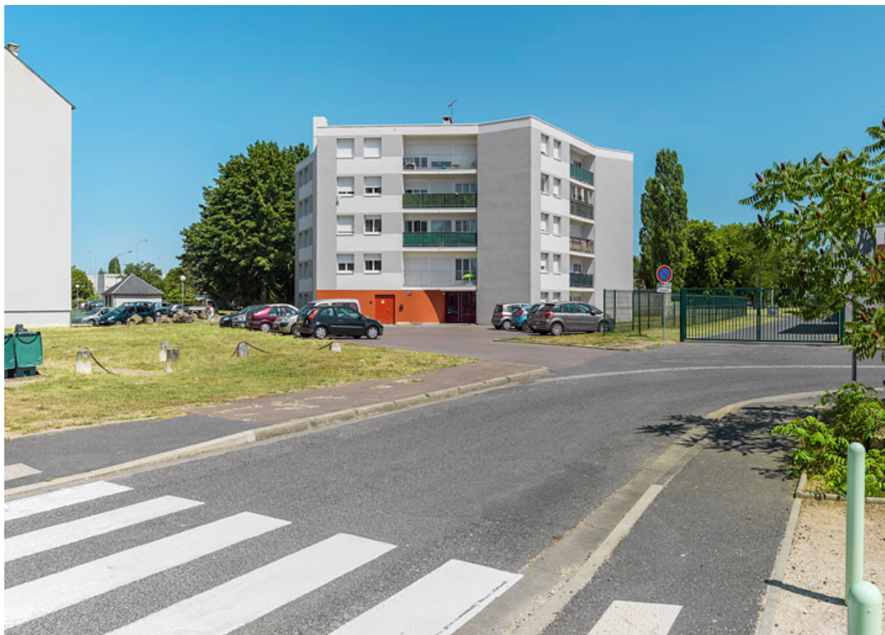
Bâtiment X, façades sud-ouest.
