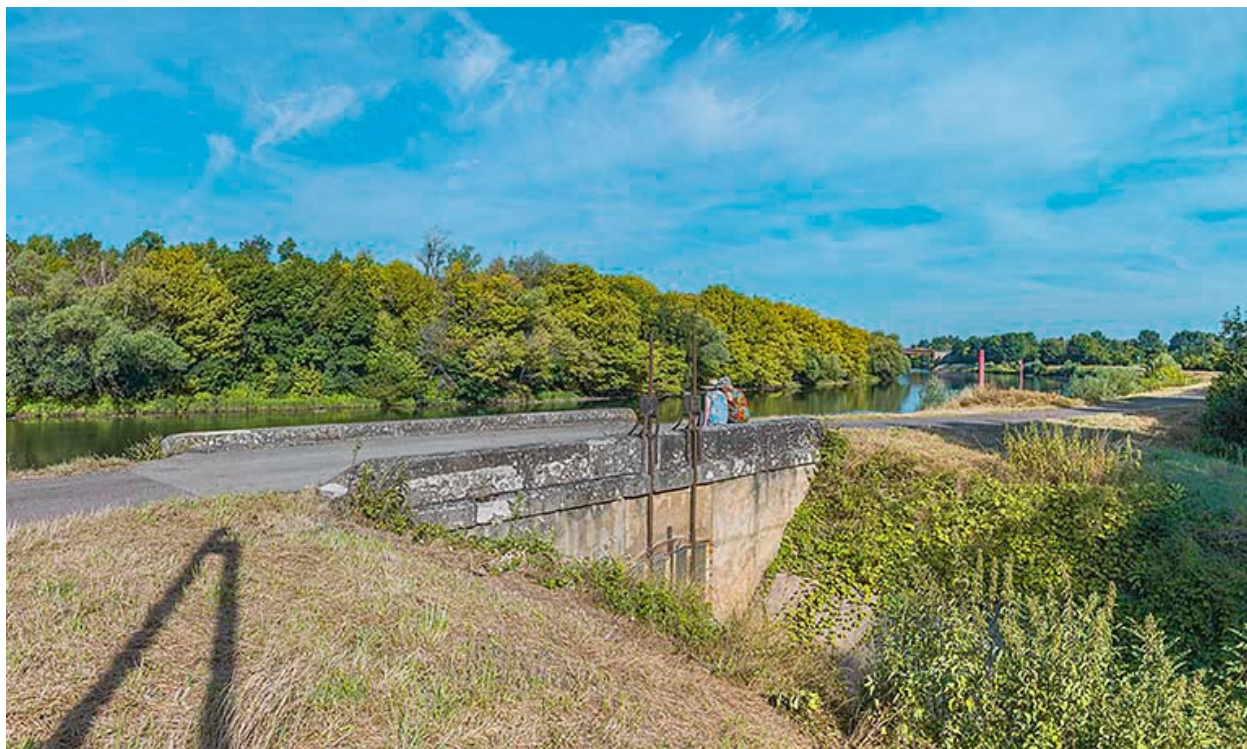
Vue d'ensemble du ponceau.
